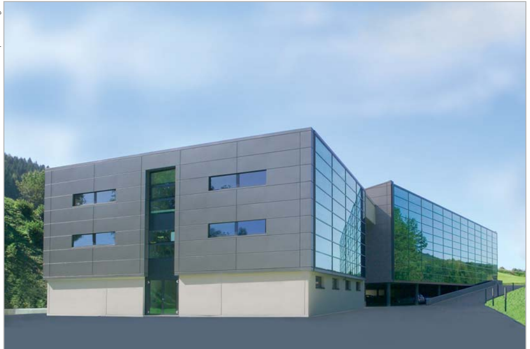
Vue générale du nouveau bâtiment Precitrame Machines SA
